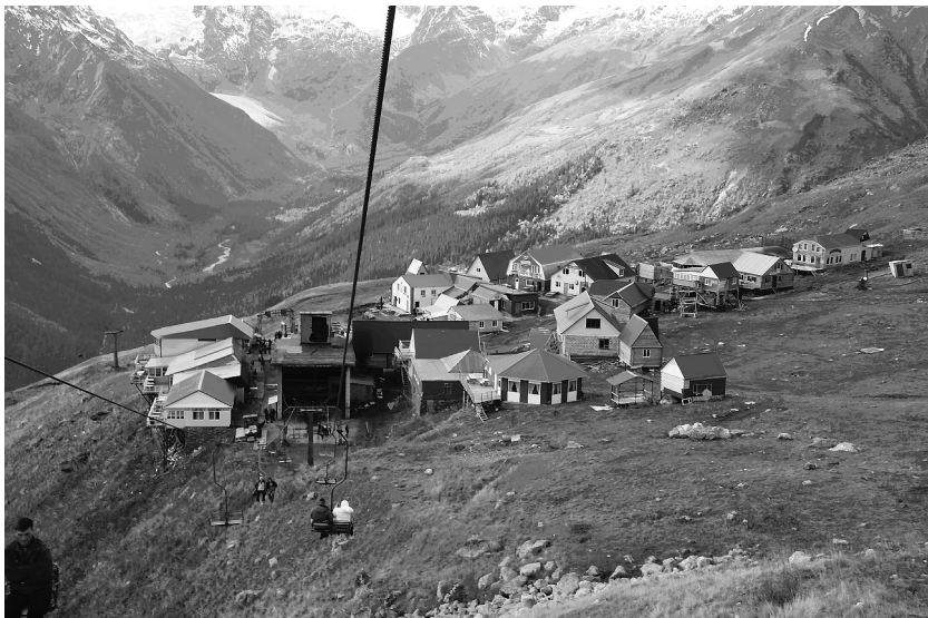
Рис. 6.2. Домбай. Третья очередь канатной дороги
