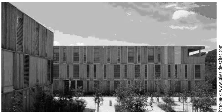
Рис.11. Общий вид технопарка Lakeside Science and technology park
